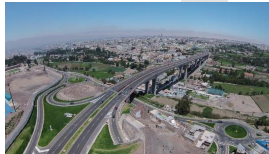
Puente Chilina, GR Arequipa
