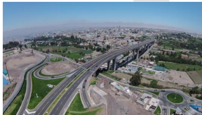
Puente Chilina, GR Arequipa
