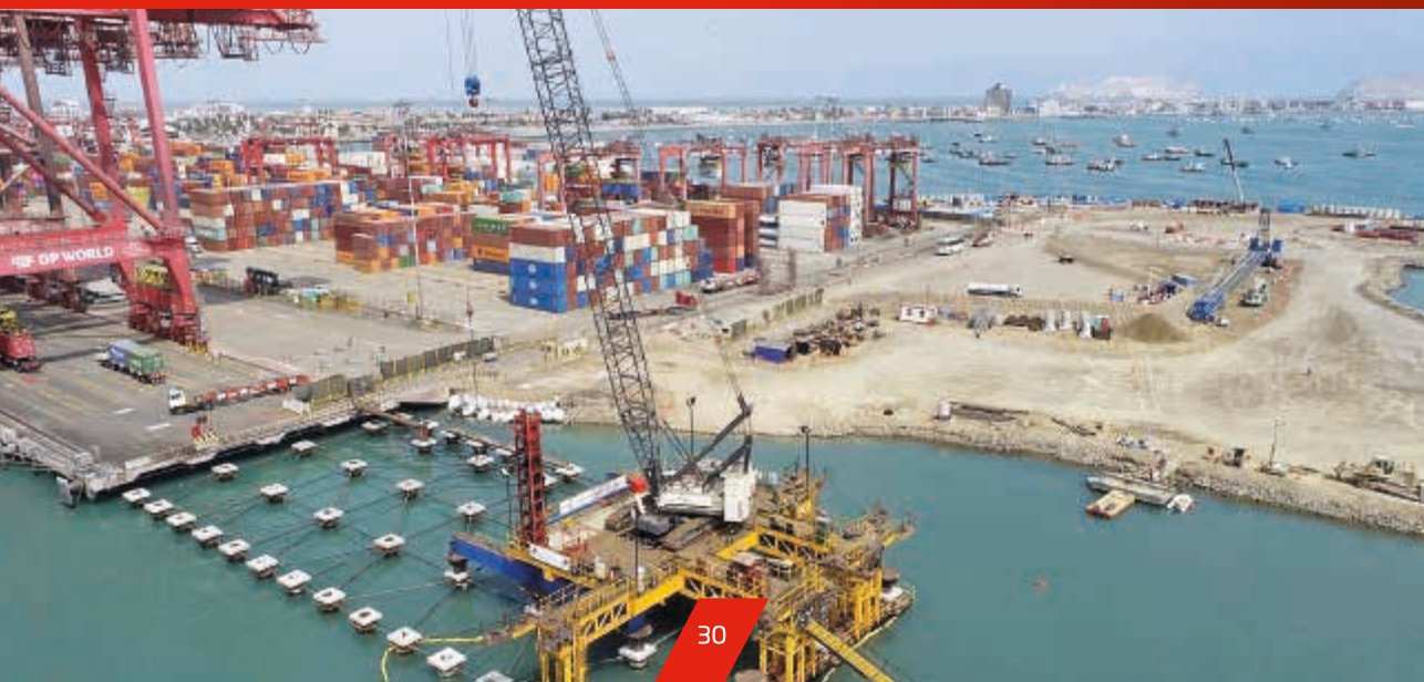
Obras en el Terminal Muelle del Sur del Callao
