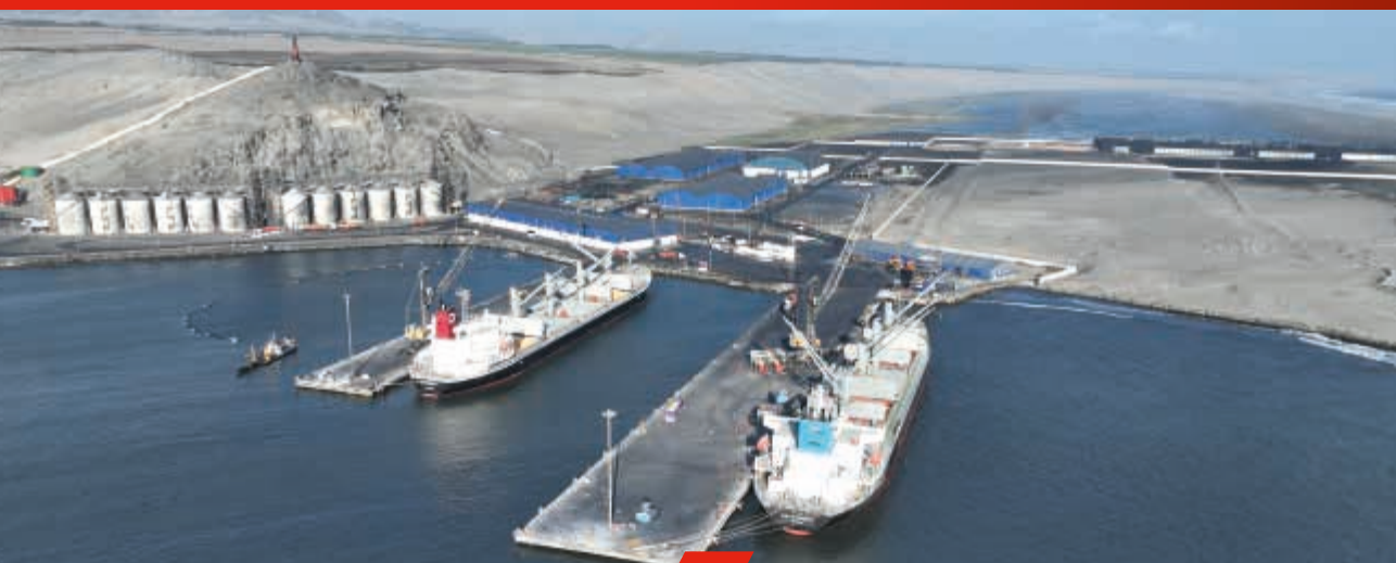
Terminal Portuario Multipropósito de Salaverry
