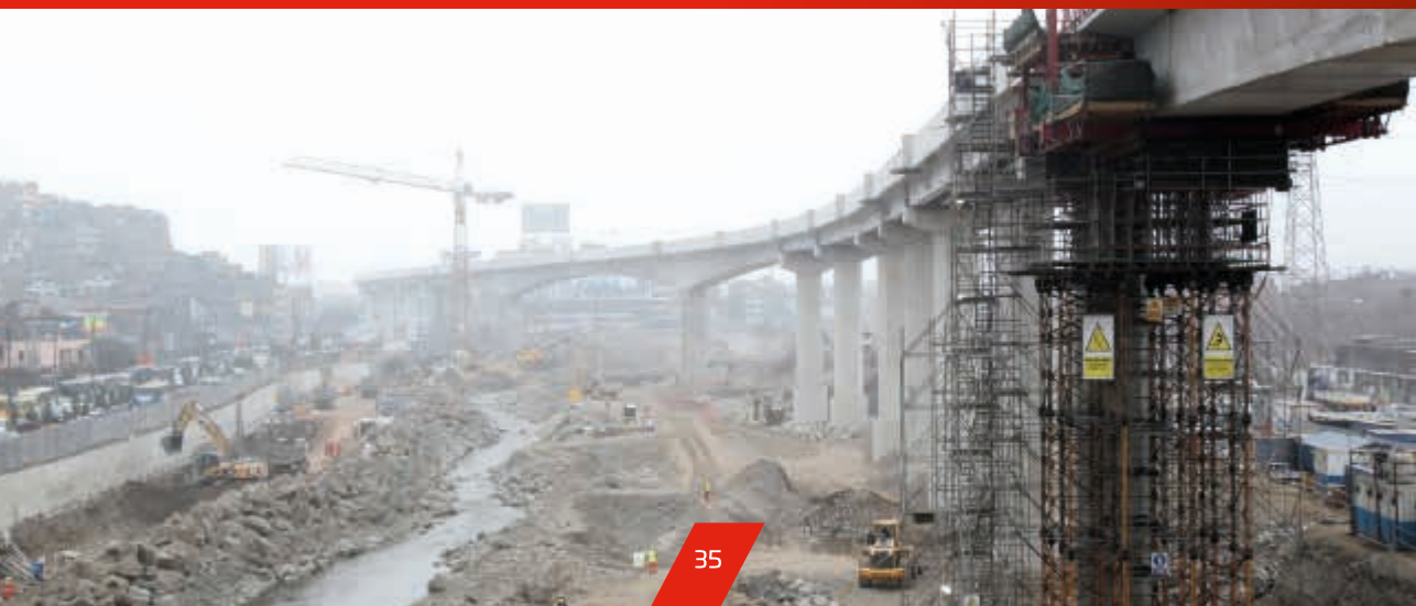
Obras del segundo tramo de la Línea 1 del Metro de Lima
