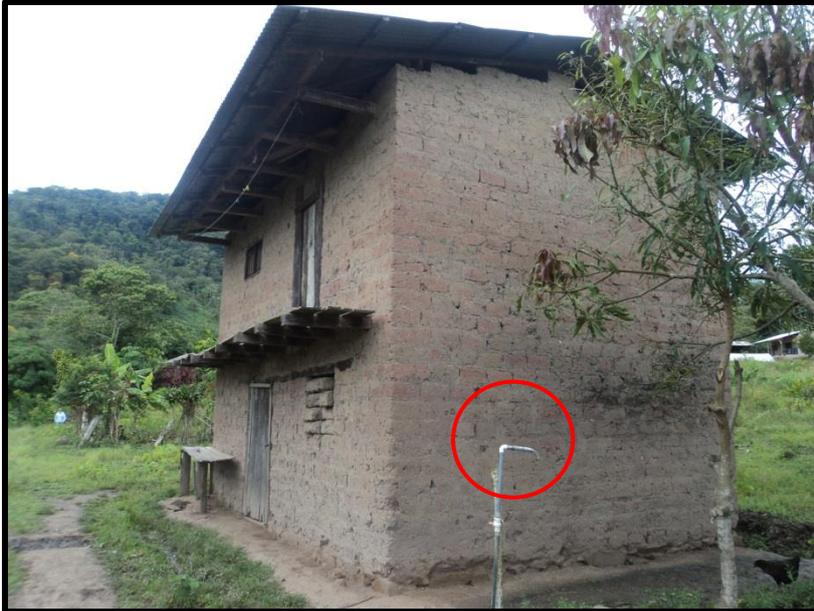
En esta vista se observa las conexiones de agua en forma desordenada.
