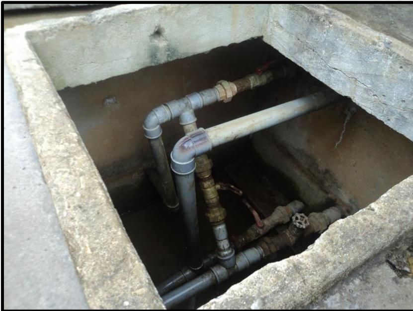
En esta imagen se aprecia el mal estado que se encuentran las tuberías, válvulas y accesorio del Reservorio del caserío Miraflores del Bajo Mayo.
