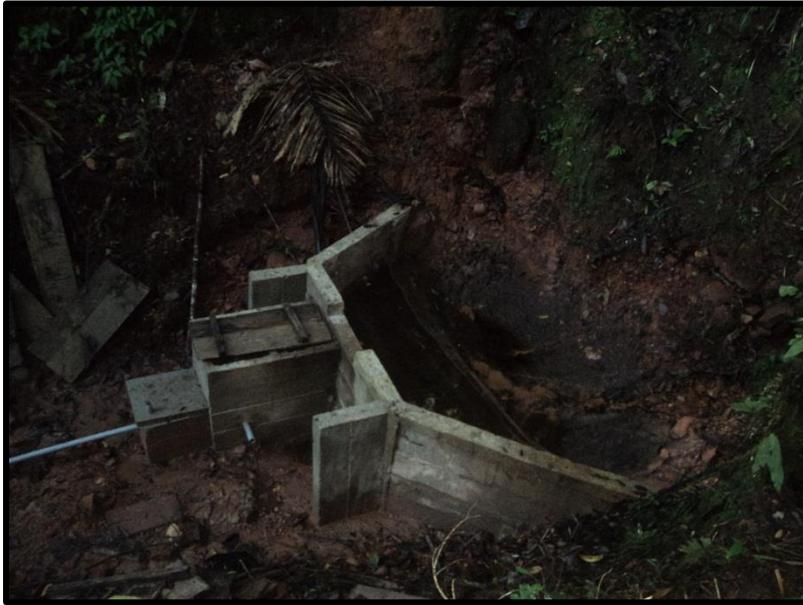
Esta imagen nos muestra la captación en total descuido, llena de hojarascas, se puede apreciar la tubería que tiene un diámetro que no es la apropiada para abastecer al caserío La Victoria.
