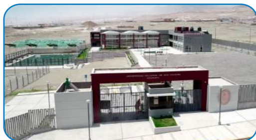
MEJORAMIENTO DE LA SEDE MOLLENDO DE LA UNSA
