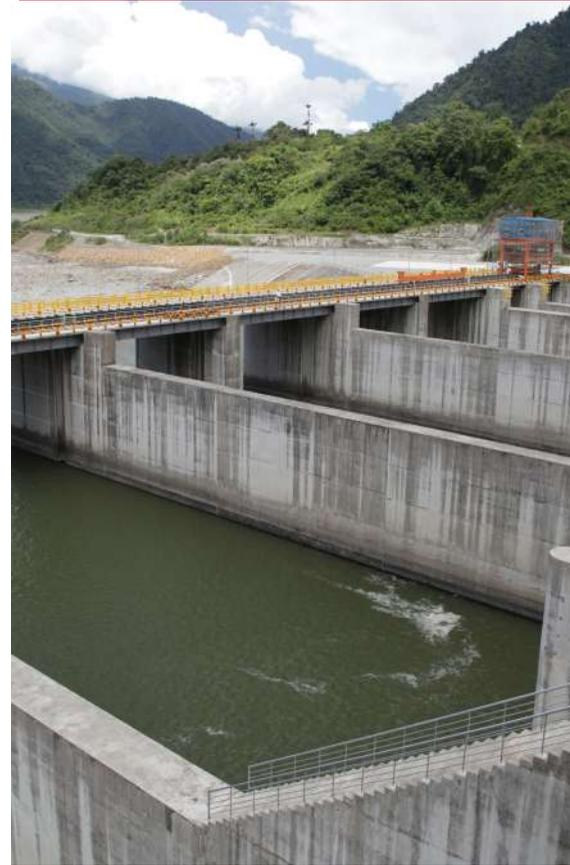
**Descripción del proyecto:** Consiste en la construcción de la central hidroeléctrica de 7,500 MW, con un caudal de diseño de 3,500 m<sup>3</sup>/s, caída bruta de diseño de 161 m, una producción anual de energía de 41,000 GWh y un embalse de 21.75 MMm<sup>3</sup>.
