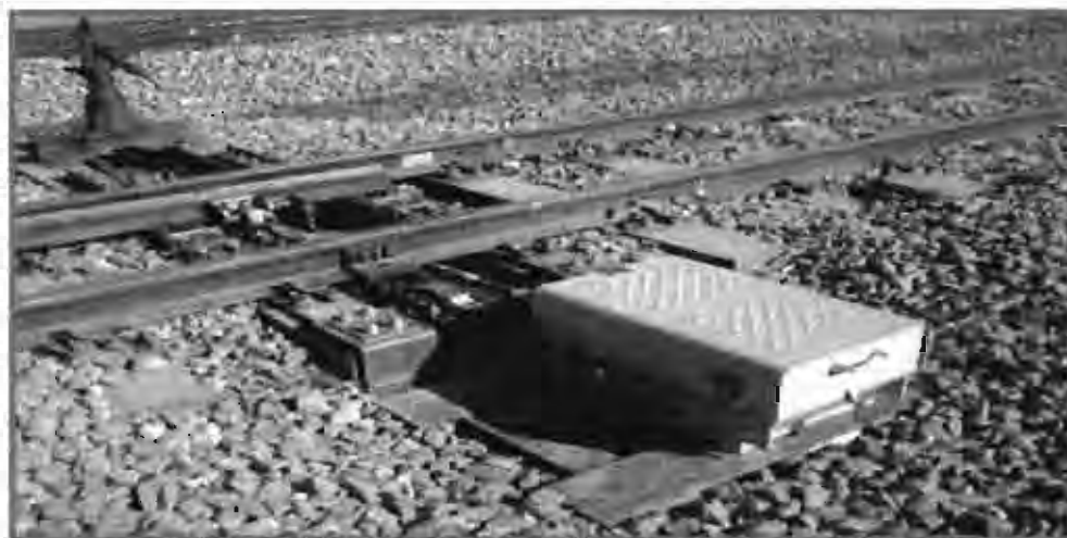
Anexo 6 - Figura N° 27: Imagen referencial de accionamiento electromecánico
