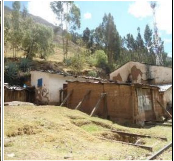
FOTO DE ZONA LATERAL SUR
