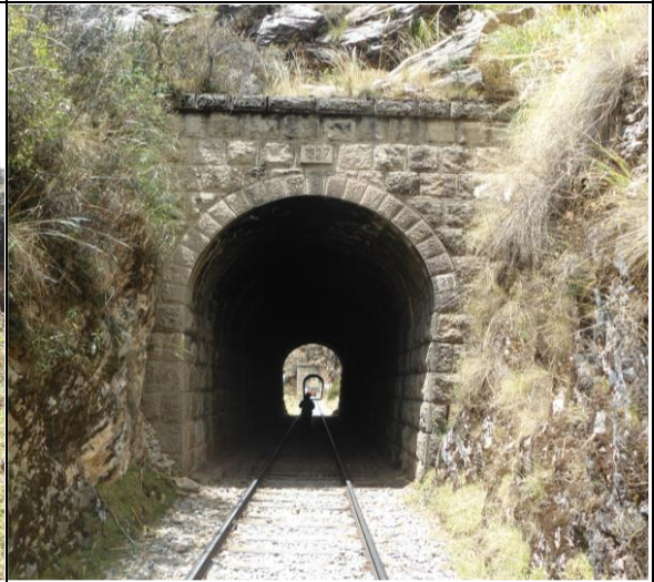
FOTO TÚNEL - ZONA SUR
