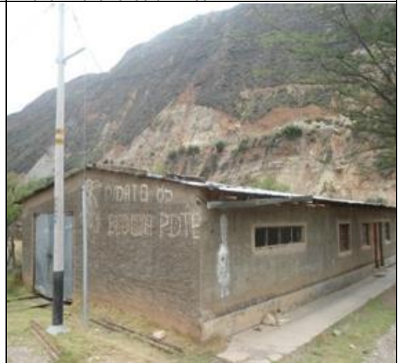
FOTO DE CASA SECCION 2 - SUR
