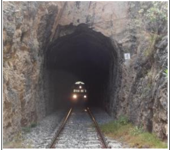
FOTO TÚNEL - ZONA SUR
