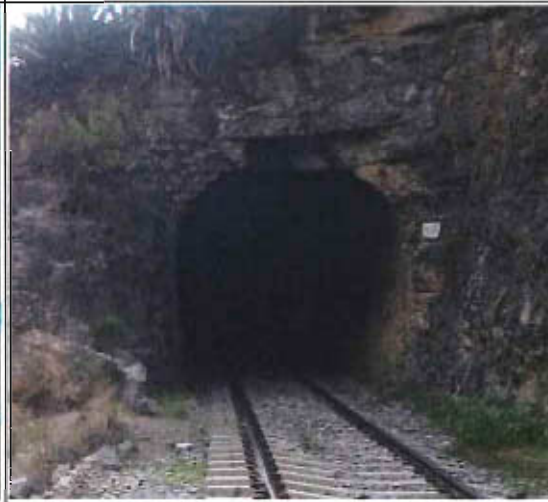
FOTO TÚNEL - ZONA SUR
