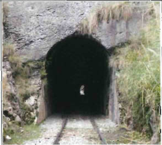
FOTO TÚNEL - ZONA SUR
