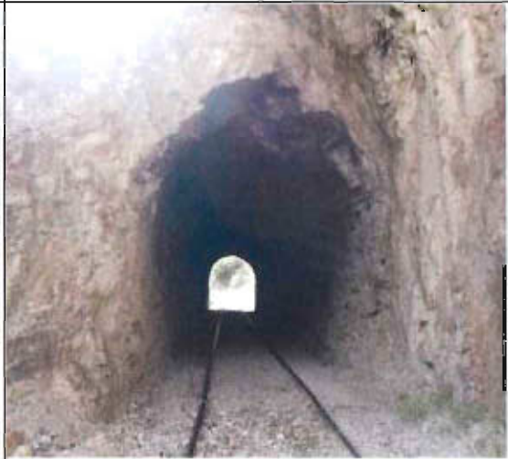
FOTO TÚNEL - ZONA SUR
