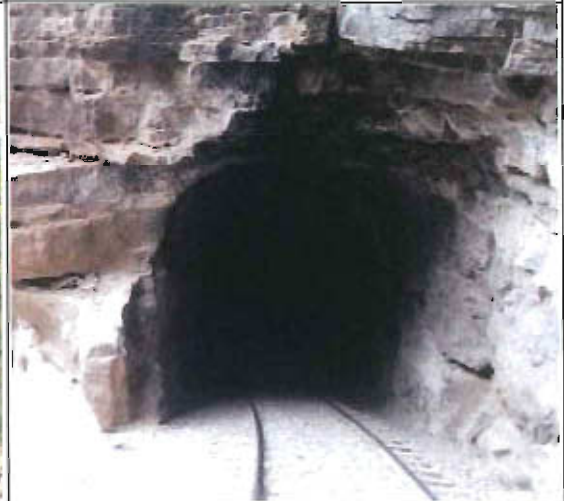
FOTO TÚNEL - ZONA SUR
