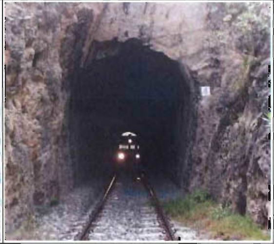
FOTO TÚNEL - ZONA SUR
