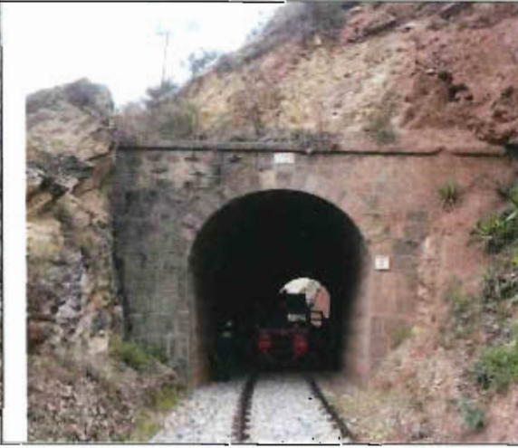
FOTO TÚNEL - ZONA SUR
