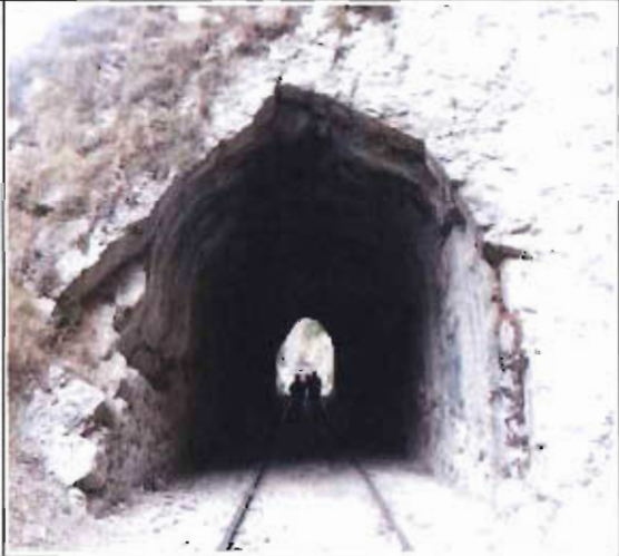
FOTO TÚNEL - ZONA SUR
