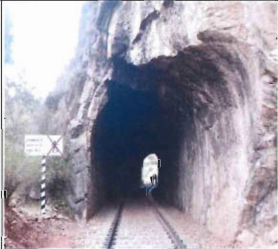
FOTO TÚNEL - ZONA SUR
