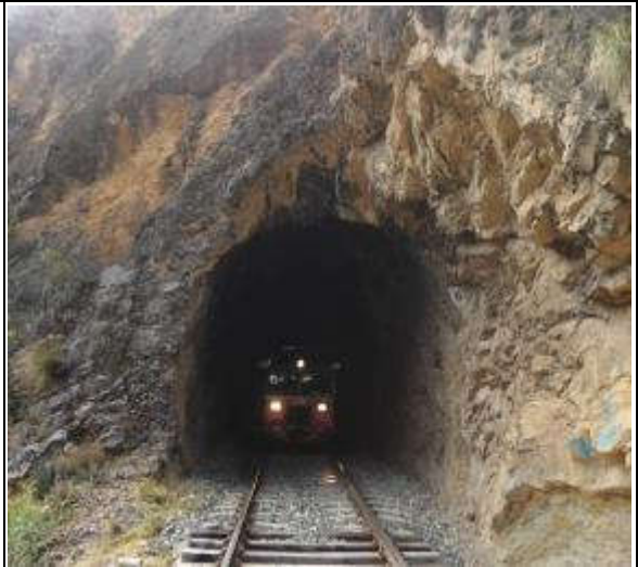
FOTO TÚNEL - ZONA SUR
