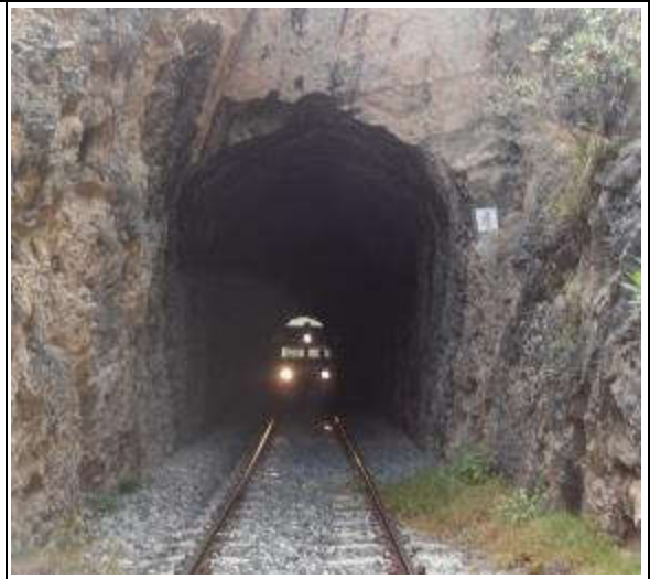
FOTO TÚNEL - ZONA SUR
