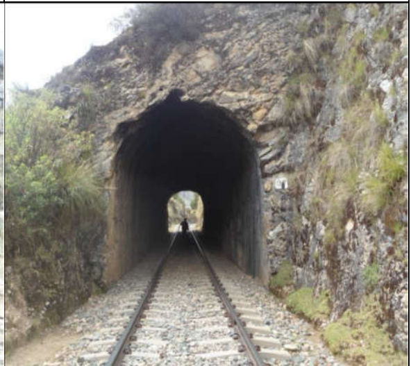
FOTO TÚNEL - ZONA SUR
