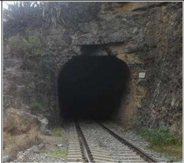
FOTO TÚNEL - ZONA SUR
