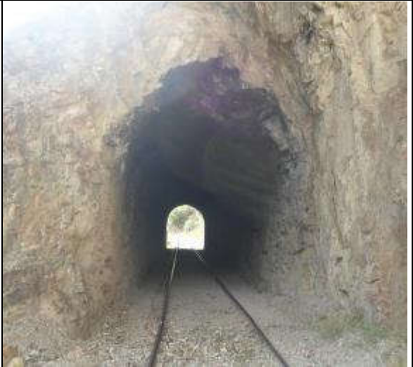
FOTO TÚNEL - ZONA SUR
