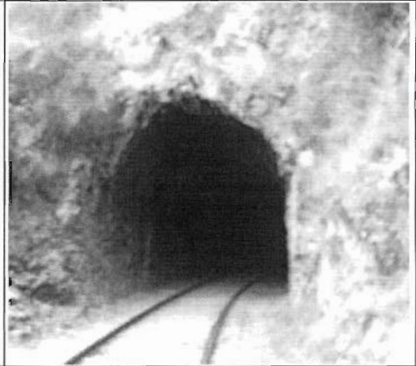
FOTO TÚNEL - ZONA SUR
