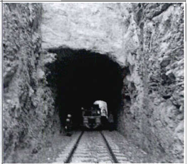
FOTO TÚNEL - ZONA SUR
