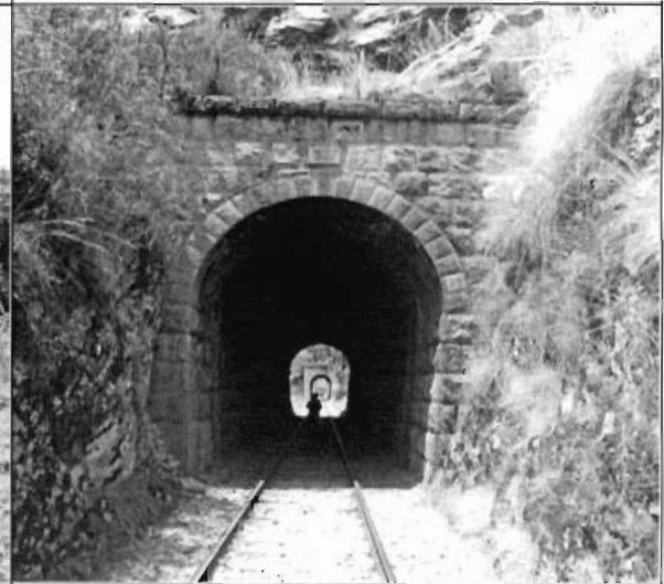
FOTO TÚNEL - ZONA SUR
