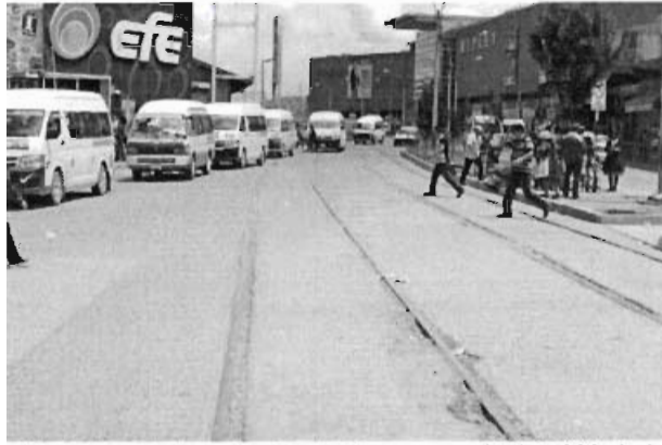
Anexo 6 - Figura N° 13: Salida de la estación de Huancayo. (PK 0+200 de la línea actual, Jr. Ica) Fuente: Elaboración Consultor Consorcio TGGT
