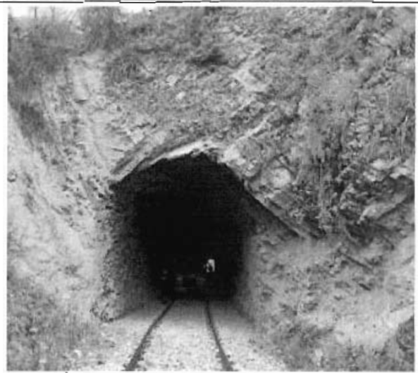
FOTO TÚNEL - ZONA SUR
