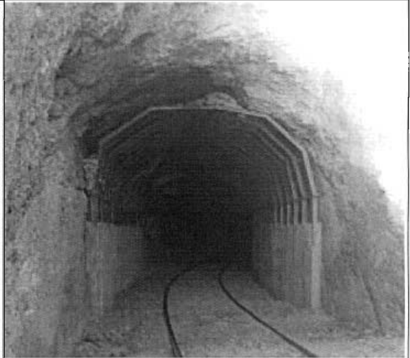
FOTO TÚNEL - ZONA SUR
