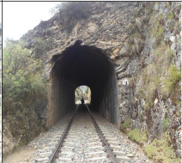
FOTO TÚNEL - ZONA SUR
