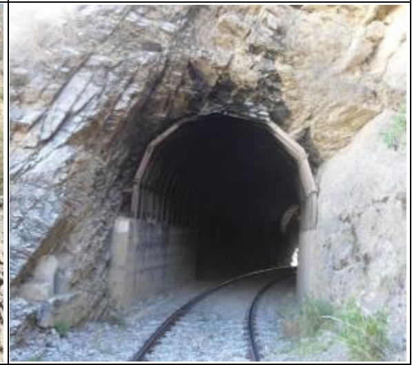
FOTO TÚNEL - ZONA SUR
