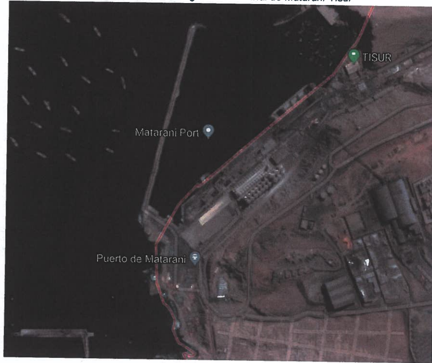
Ilustración 2.38: Imagen del Terminal de Matarani-Tisur
