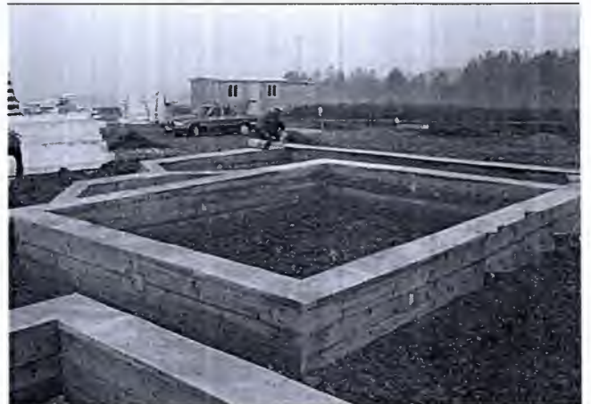
Gráfico N° 95: Vigas de cimentación superficial para los nodos de la Red de Acceso – Alt. 2
