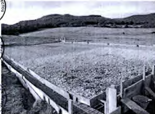
Gráfico N° 95: Vigas de cimentación superficial para los nodos de la Red de Acceso – Alt. 2
