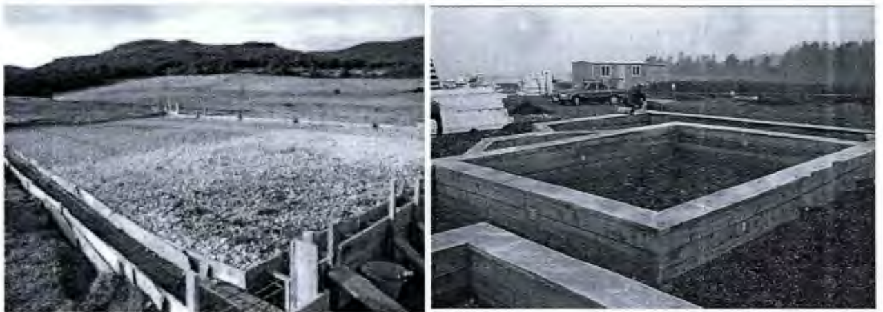
Gráfico N° 76: Vigas de cimentación superficial para los nodos de la Red de Acceso
