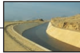
Prolongación del Canal Madre tramo Moche - Chicama - Urricape
