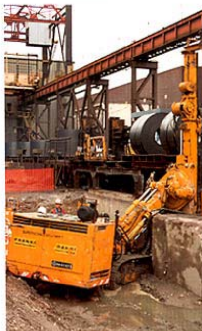
Instalación de Micropilotes-Anclajes TITAN 103/78, longitud 18 m, en una acería en pleno funcionamiento.
