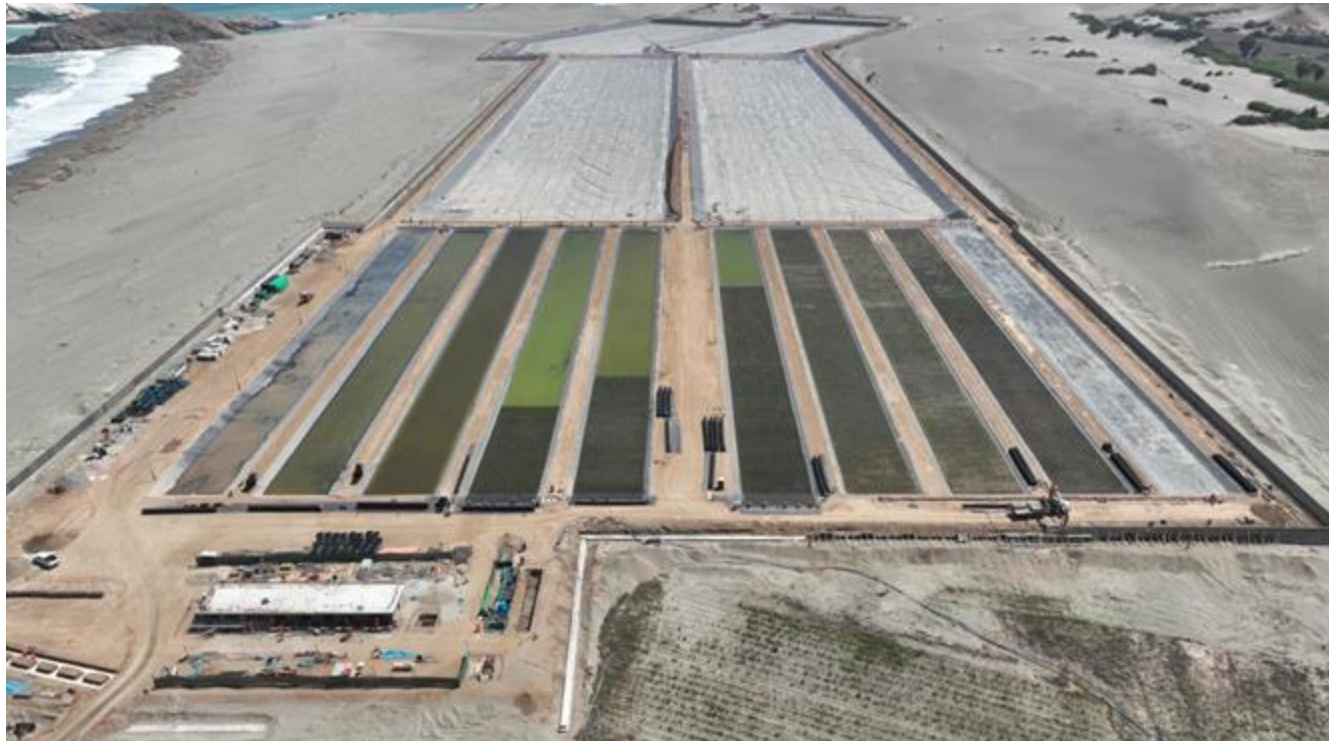
Planta de Tratamiento de Agua Residual (PTAR)
