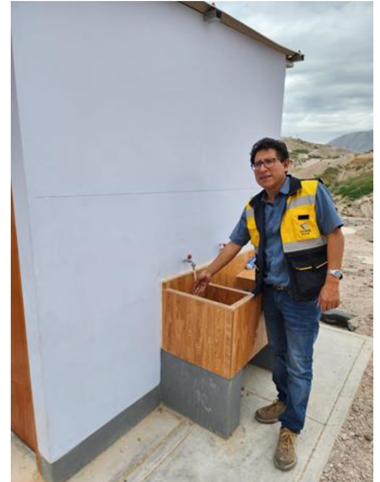
Unidad Básica de Saneamiento (UBS)
