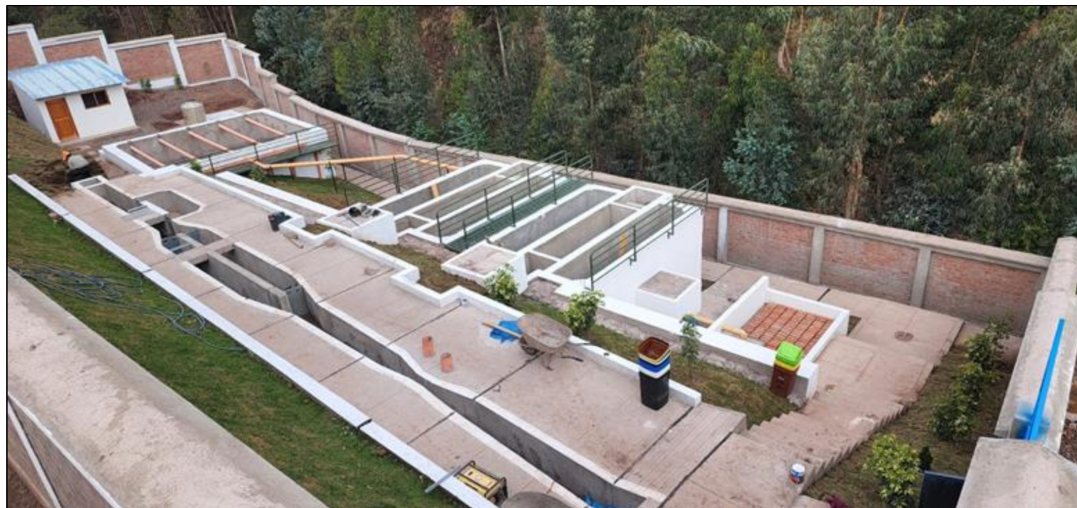
Planta de Tratamiento de Agua Residual (PTAR)
