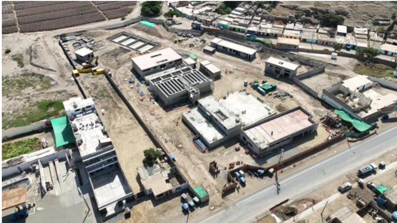
Planta de Tratamiento de Agua Potable (PTAP)
