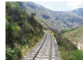
Vía férrea Valle del Mantaro
