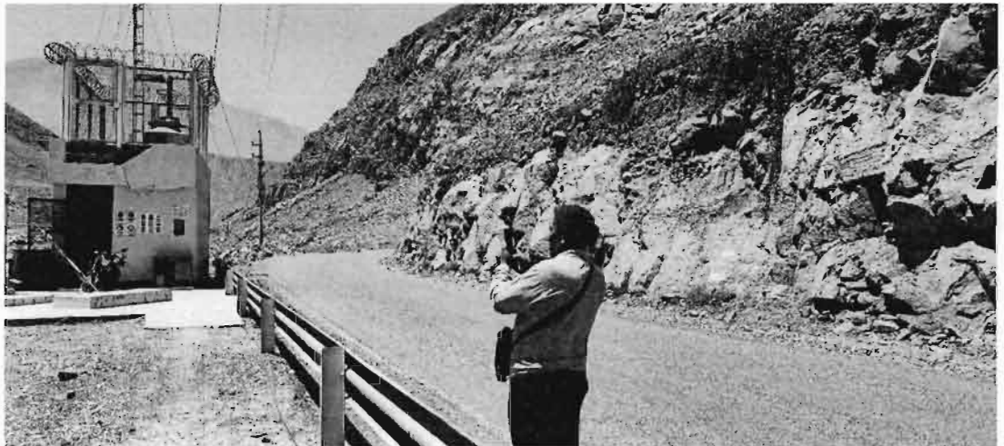
Foto N° 06.- Zona de la Estación Condorcerro en el río Santa; predominan los afloramientos de rocas intrusivas graníticas que se muestran diaclasadas y conformando taludes superiores a 35 grados, parcialmente cubiertos por coluvios.
