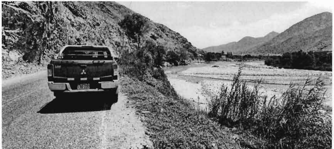
Foto N° 10.- Vista aguas abajo de la Zona de Captación Tablonas (captación más baja), flanco izquierdo del valle con afloramientos de rocas graníticas fracturadas y diaclasadas. En el lecho del río, se observan acumulaciones granulares de origen fluvio aluvional, que podrían aportar materiales para la elaboración de agregados para concreto.
