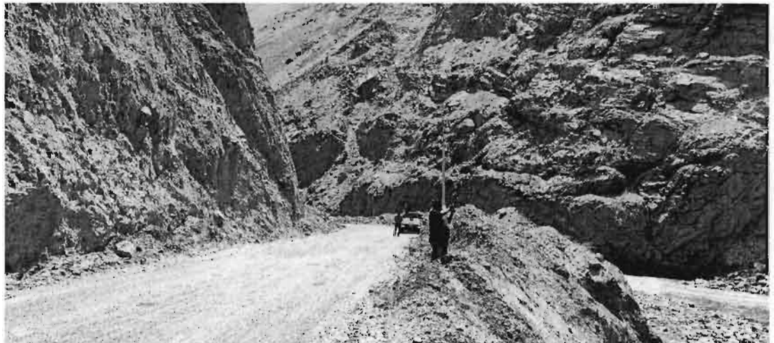
Foto N° 01.- Alternativa Baja de la Captación Chuquicara en el río Santa; aguas arriba de la confluencia con el río Tablachaca. Flanco izquierdo con terrazas aluvionales con taludes superiores a 40 grados.
