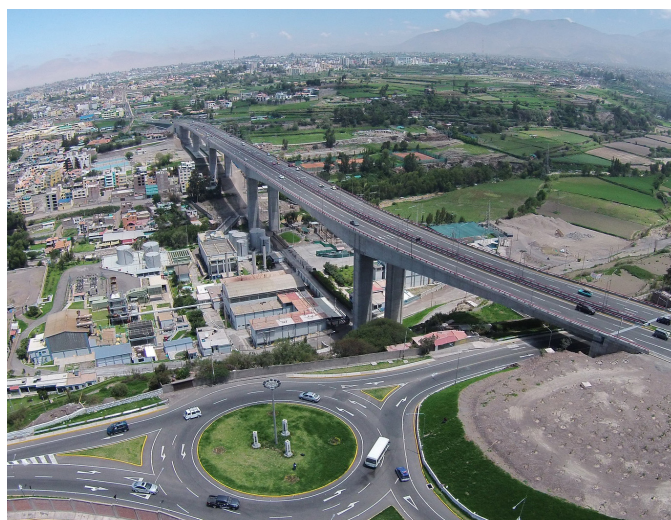
Puente Chilina - Arequipa.
