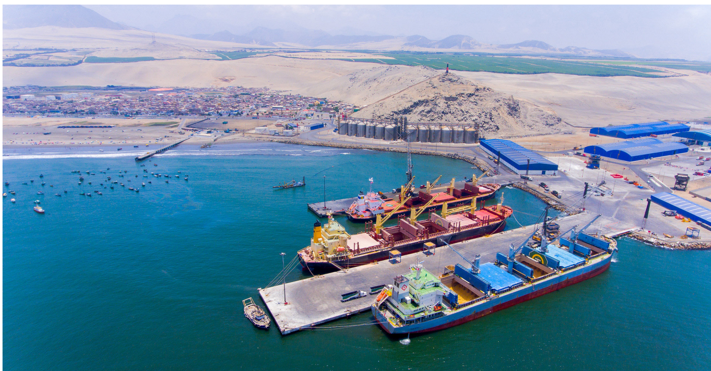
Terminal Portuario Multipropósito de Salaverry.
