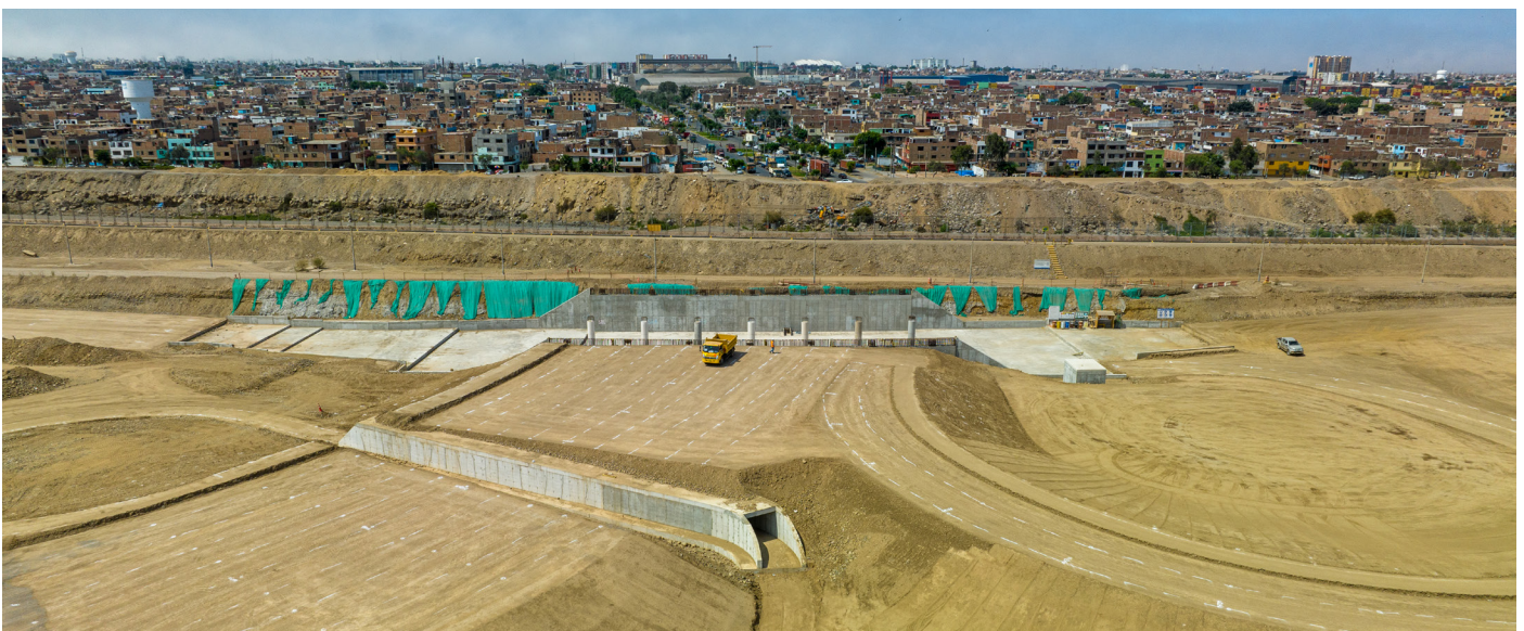
Construcción Vía Expresa Santa Rosa (Callao).
