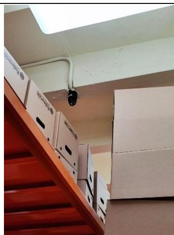
Se verifico que en el archivo ubicado en el sótano se han instalado detectores de humo, sin embargo, estos no funcionan y las cantidades que hay son insuficientes.
