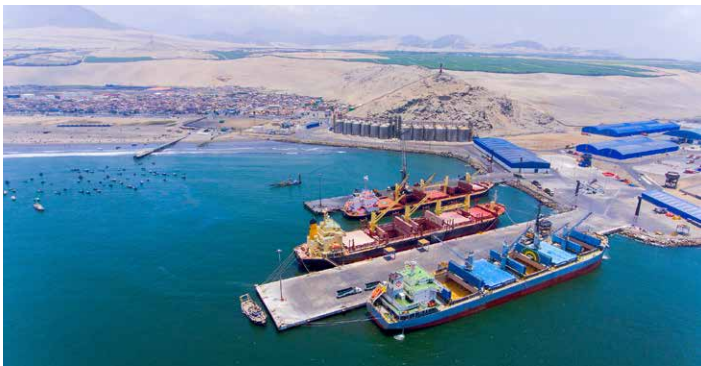
Terminal Portuario Multipropósito de Salaverry.
