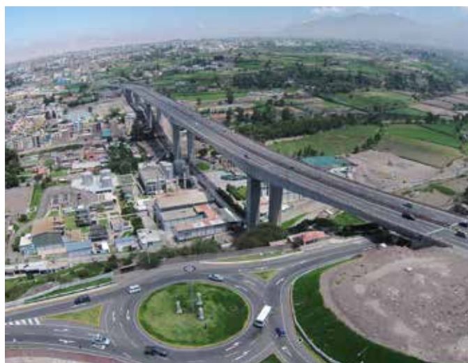
Puente Chilina - Arequipa.
