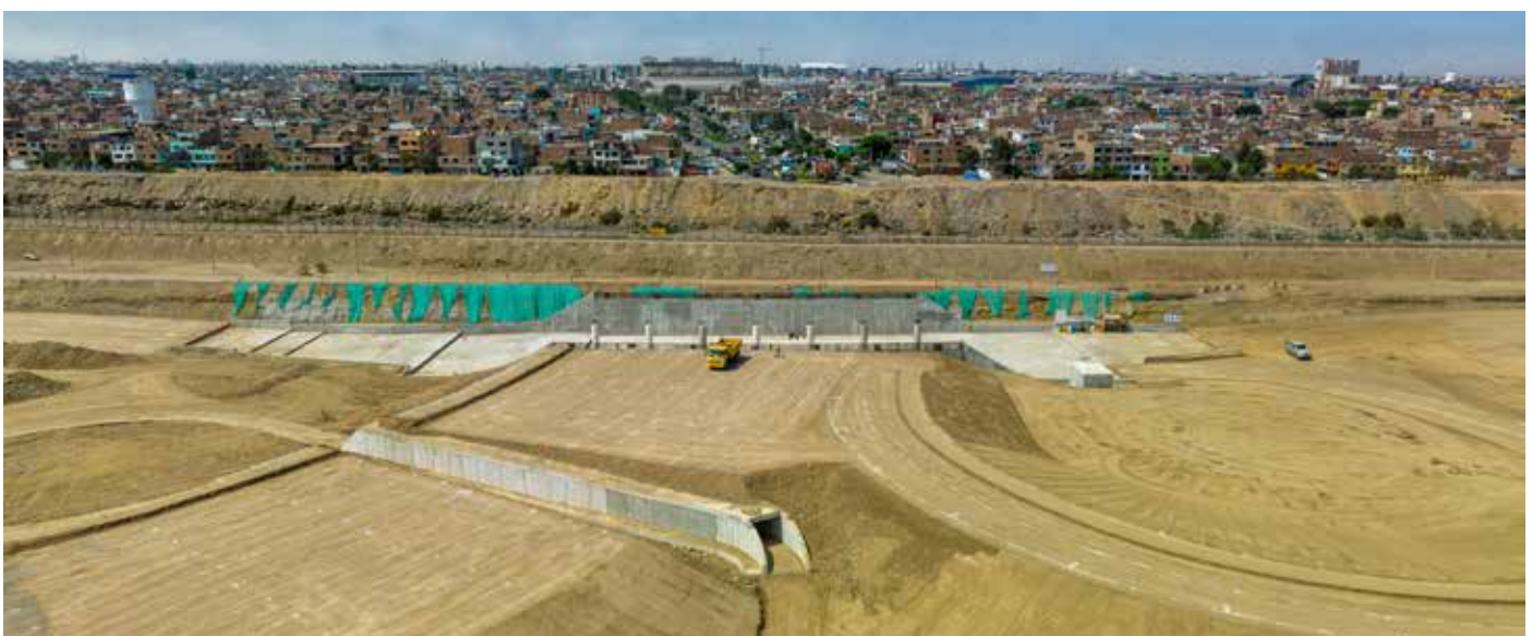
Construcción Vía Expresa Santa Rosa (Callao).
