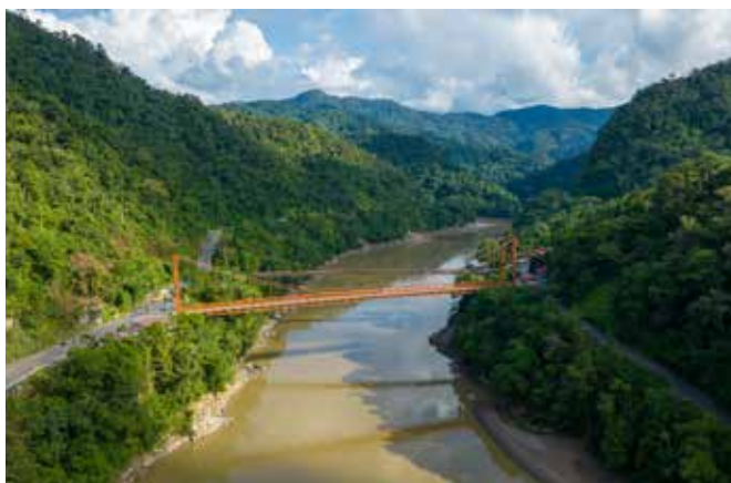
IIRSA Sur - Tramo 2-3 Puente Inambari, Puerto Maldonado
