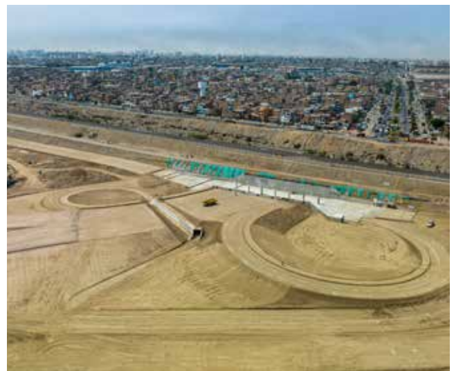
Construcción del Puente Santa Rosa
