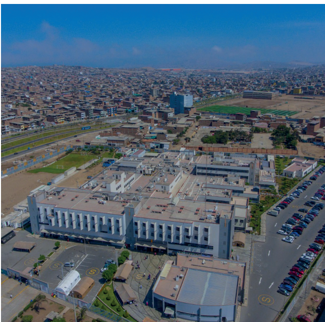
Exteriores del Hospital de Villa El Salvador
