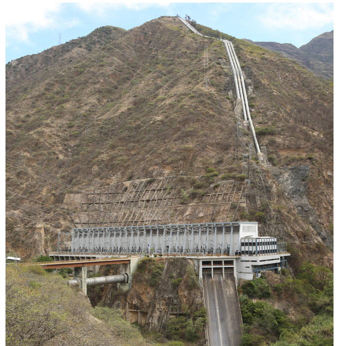
Línea de Transmisión 500 kV Mantaro - Marcona - Socabaya - Montalvo y Subestaciones Asociadas
