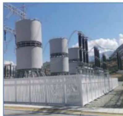
S.E. Colcabamba: reactor serie 220 kV
