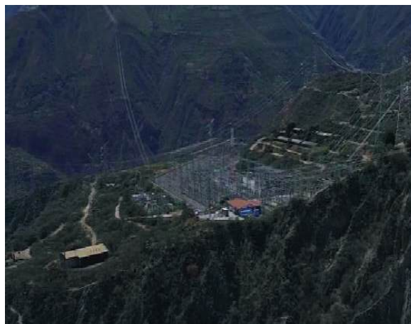
Ilustración 40 Subestaciones proyecto MAMO
