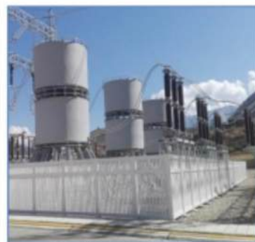
S.E. Colcabamba: reactor serie 220 kV
