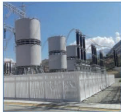
S.E. Colcabamba: reactor serie 220 kV
