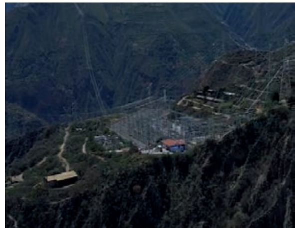
Ilustración 40 Subestaciones proyecto MAMO
