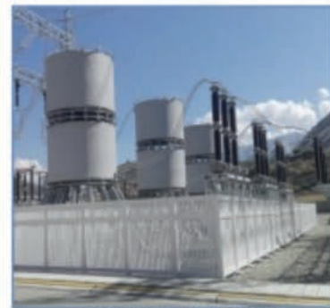
S.E. Colcabamba: reactor serie 220 kV
