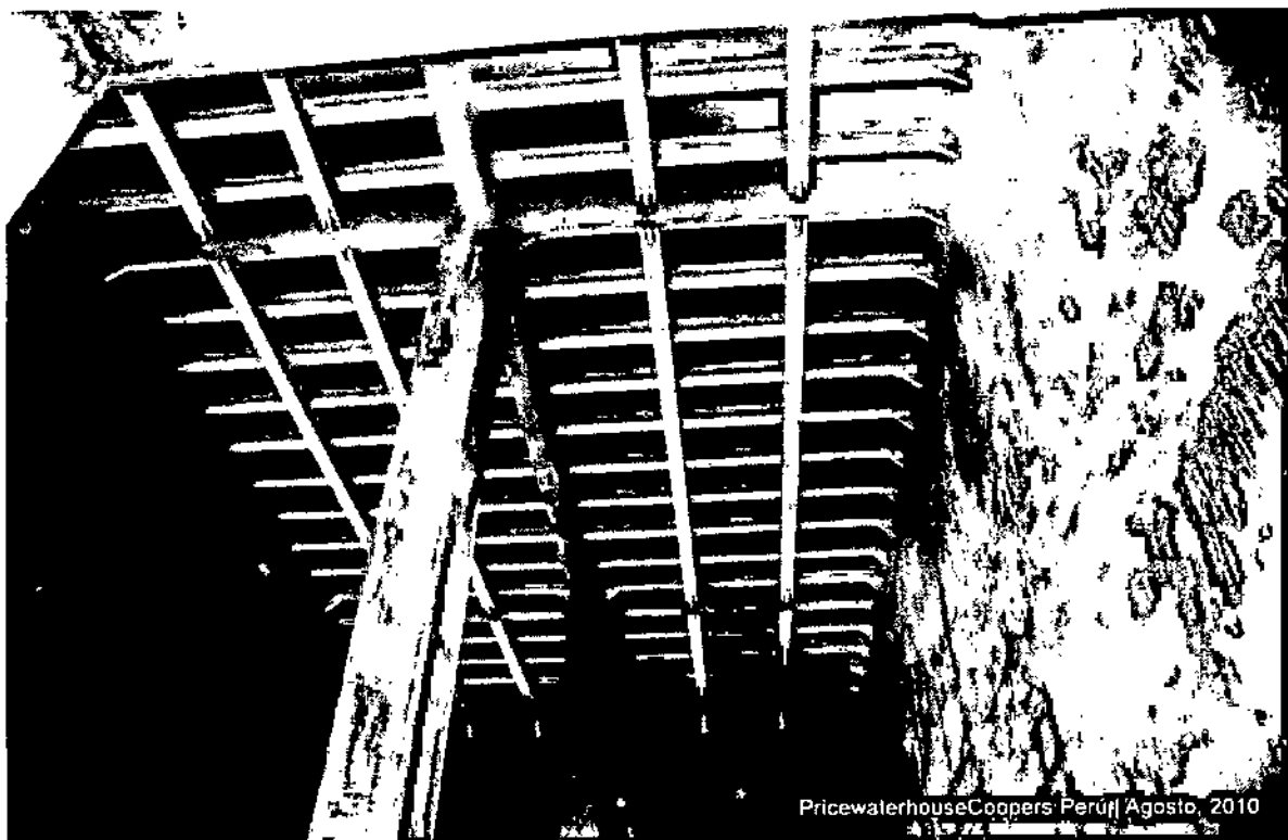
Fotografía 2: Techo de la torre de enfriamiento
