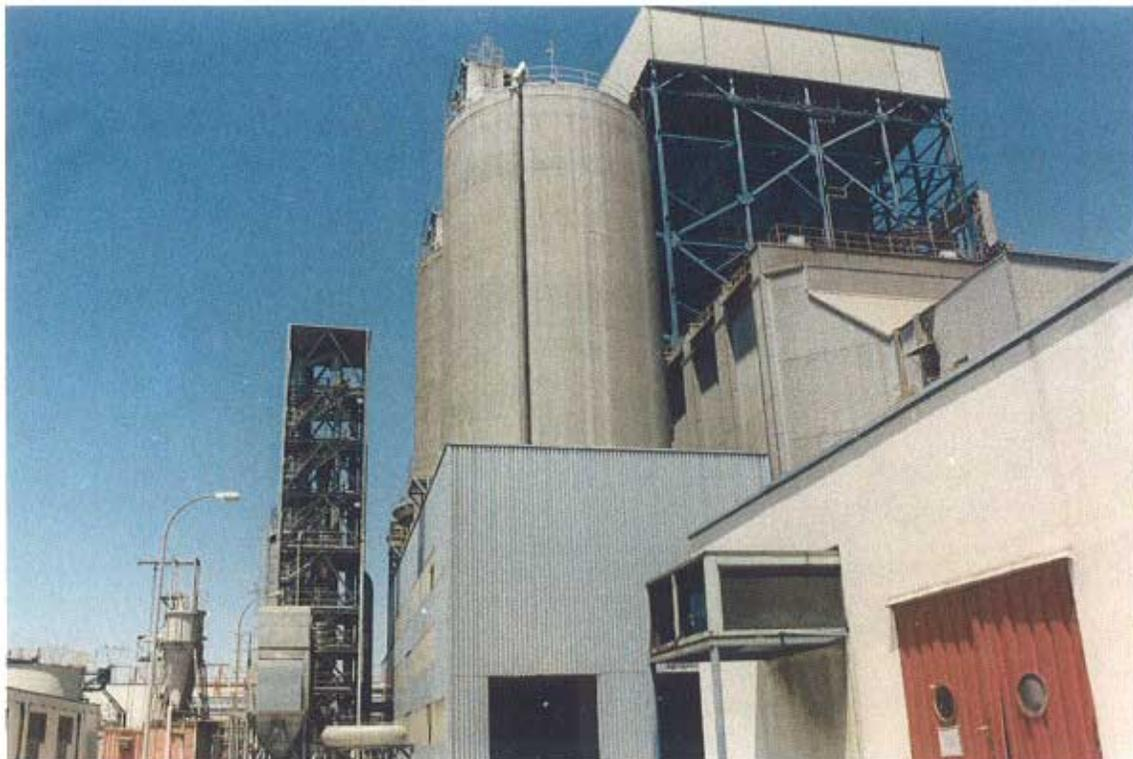
Silos de cenizas volantes de Central Térmica que son recicladas para la fabricación de cementos.
