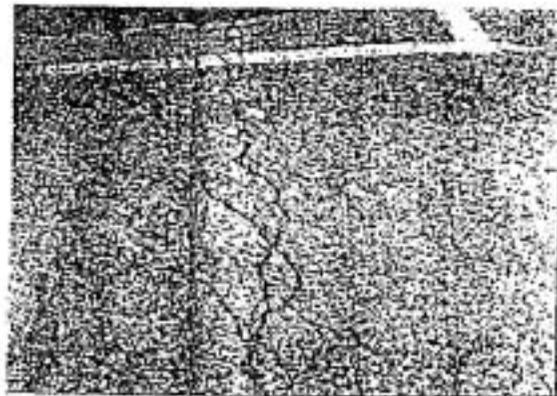
Fig. X1.20 Fisura de Borde - Mediana Severidad
