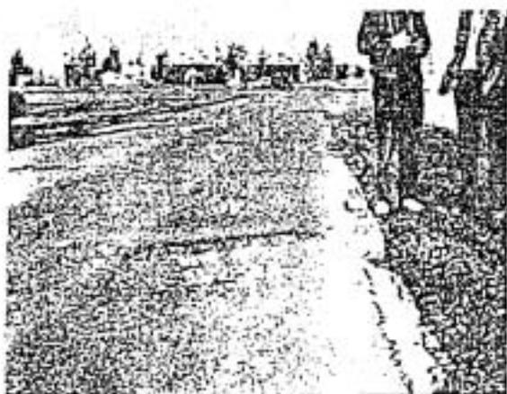
Fig. X1.11 Abultamientos y Hundimientos – Mediana Severidad
