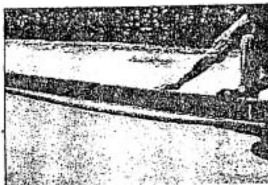
Fig. X1.17 Depresión - Mediana Severidad
