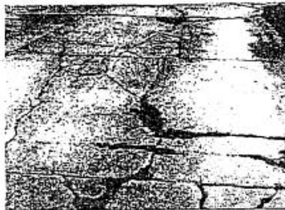
Fig. X2.9 Losa Dividida - Alta Severidad
