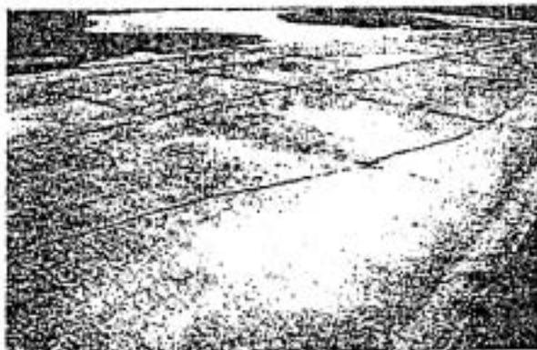
Fig. X2.7 Losa Dividida – Baja Severidad
