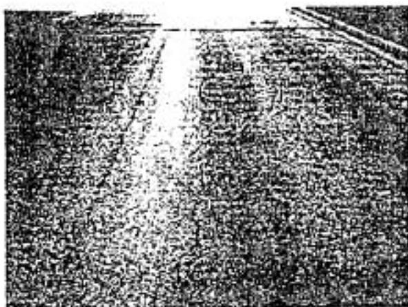
Fig. X1.1 Piel de Cocodrilo - Baja Severidad
