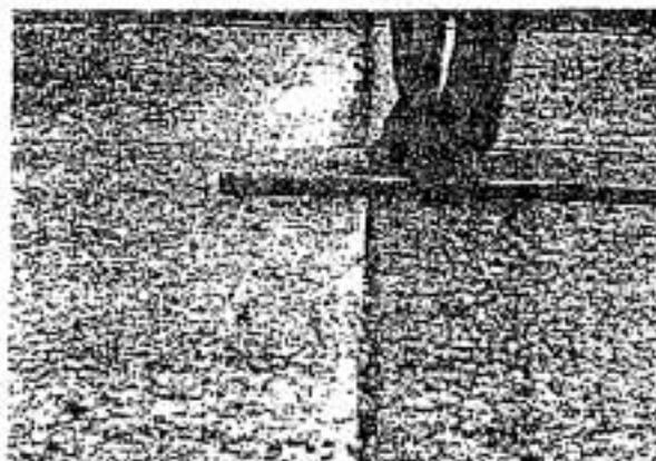
Fig. X2.13 Escalonamiento – Baja Severidad
