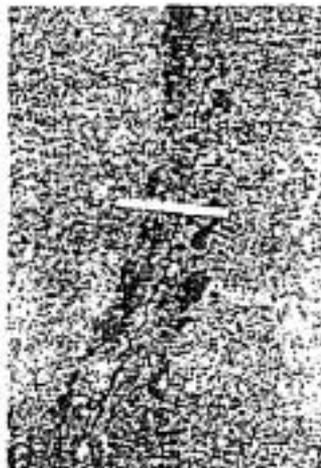
Fig. X2.22 Fisura Lineal – Baja Severidad
