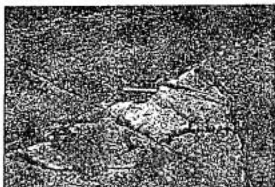
Fig. X2.6 Fractura de Esquina - Alta Severidad
