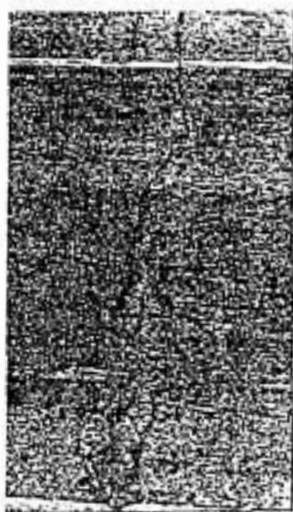
Fig. X1.23 Fisura de Reflexión de Junta - Mediana Severidad
