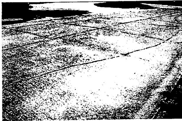
**Fig. X2.7 Losa Dividida – Baja Severidad**
