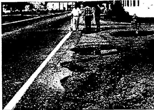
Fig. X1.21 Fisura de Borde – Alta Severidad
