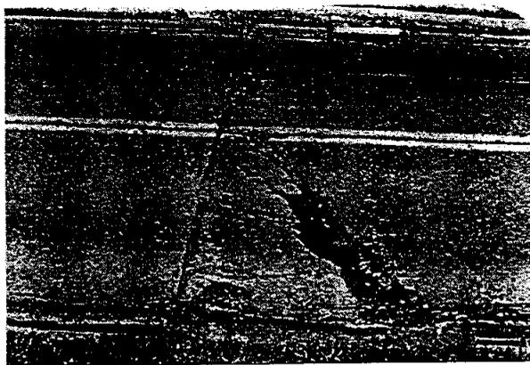
Fig. X2.36 Punzonamiento – Mediana Severidad
