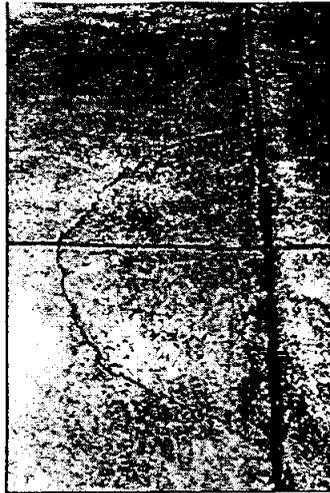
Fig. X2.4 Fractura de Esquina – Baja Severidad
