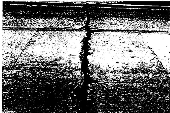
Fig. X2.16 Daño en el Sello de la Junta – Baja Severidad
