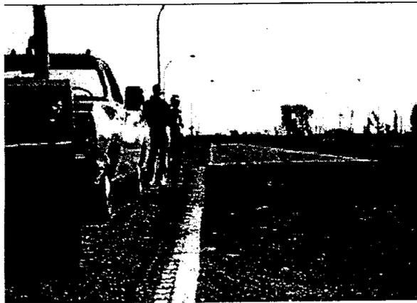
Fig. X2.3 Levantamiento/Pandeo – Alta Severidad
