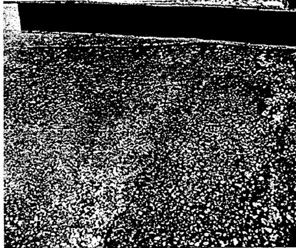
Fig. X1.12 Abultamientos y Hundimientos – Alta Severidad
