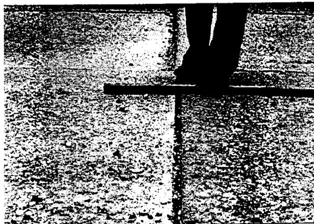
Fig. X2.13 Escalonamiento – Baja Severidad
