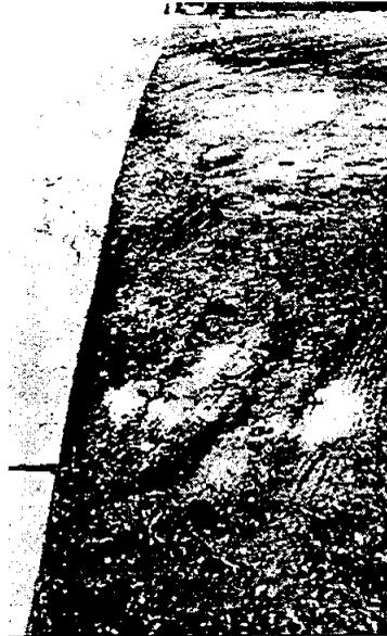
Fig. X2.20 Desnivel Carril-Berma – Mediana Severidad
