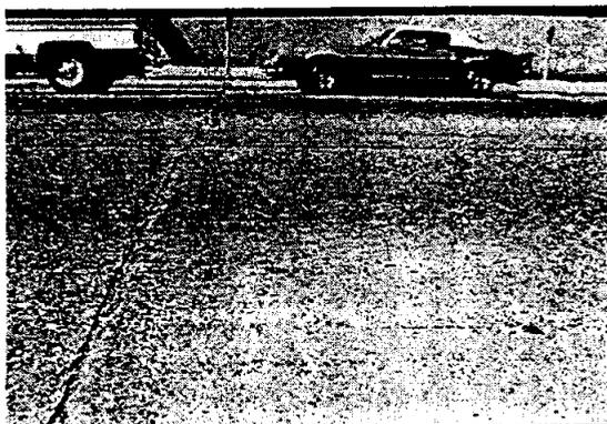
Fig. X2.48 Descascaramiento de Junta – Baja Severidad
