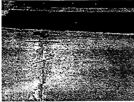
Fig. X2.1 Levantamiento/Pandeo – Baja Severidad
