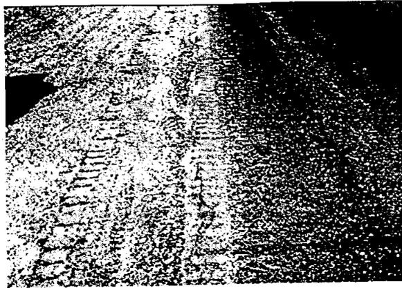
Fig. X1.22 Fisura de Reflexión de Junta – Baja Severidad
