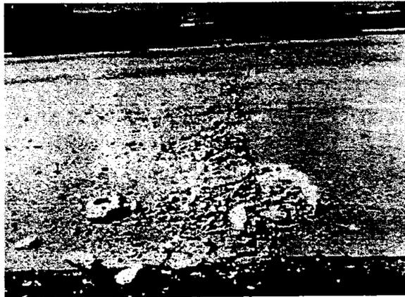
Fig. X2.2 Levantamiento/Pandeo – Mediana Severidad
