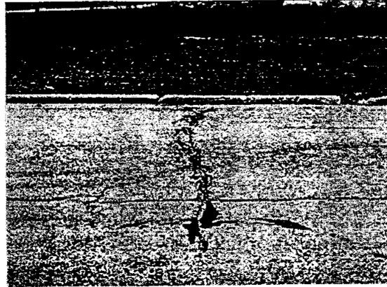
Fig. X1.30 Fisura Longitudinal y Transversal –Alta Severidad
