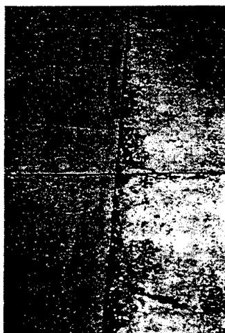
Fig. X2.49 Descascaramiento de Junta – Mediana Severidad
