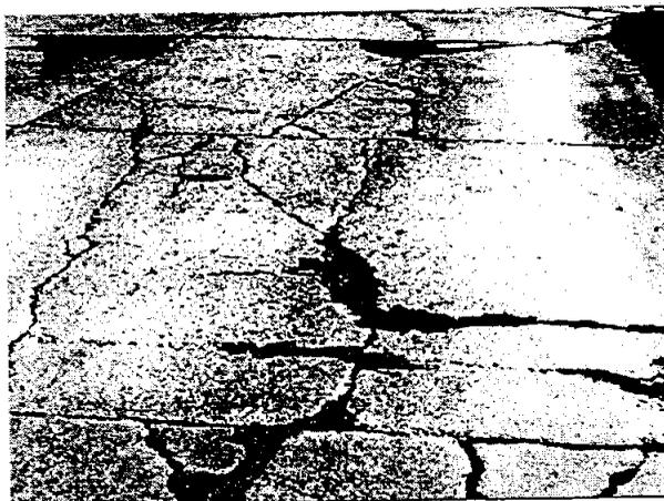
Fig. X2.9 Losa Dividida – Alta Severidad
