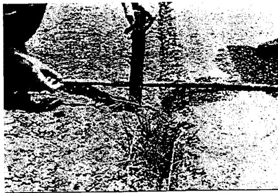
Fig. X1.26 Desnivel Carril-Berma – Mediana Severidad
