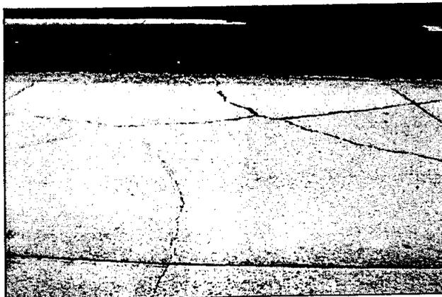
**Fig. X2.8 Losa Dividida – Mediana Severidad**
