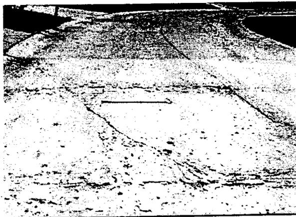
Fig. X2.12 Fisura de Durabilidad – Alta Severidad
