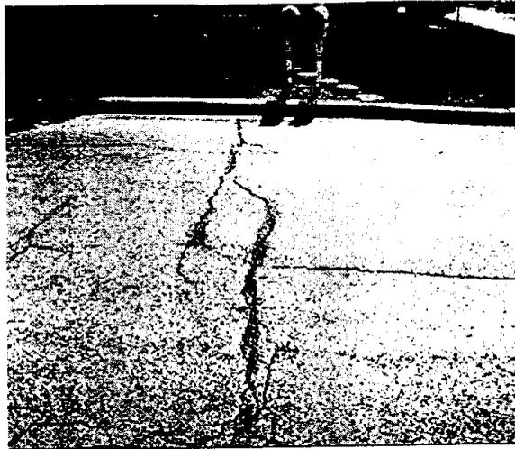
Fig. X1.8 Fisuras en Bloque – Mediana Severidad
