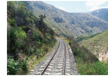
Vía férrea Valle del Mantaro
