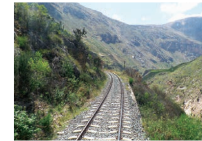
Vía férrea Valle del Mantaro
